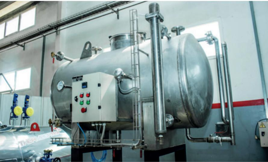
Un réservoir d'eau qui reçoit les condensats et l'eau traitée d'appoint pour alimenter la chaudière sans risque d'interruption.
