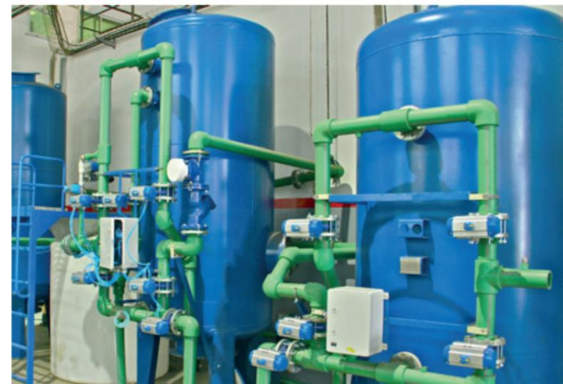
Les filtres à sable sont des dispositifs de filtration conçus pour éliminer les impuretés, les particules solides et les contaminants de l'eau ou d'autres liquides.
