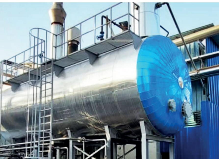
Dégazeur pour la réduction de l'oxygène ( $O_2$ ) dans l'eau d'alimentation de la chaudière. Une large gamme de capacité allant jusqu'à **100 m<sup>3</sup>**.
