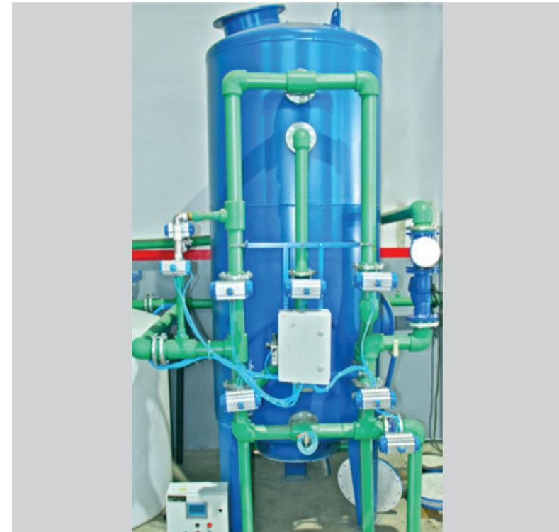
L'adoucisseur d'eau réduit la dureté de l'eau brute, ce qui évite le tartrage des équipements (chaudière, tuyauterie...), prolonge leur durée de vie et en optimise l'efficacité énergétique.
